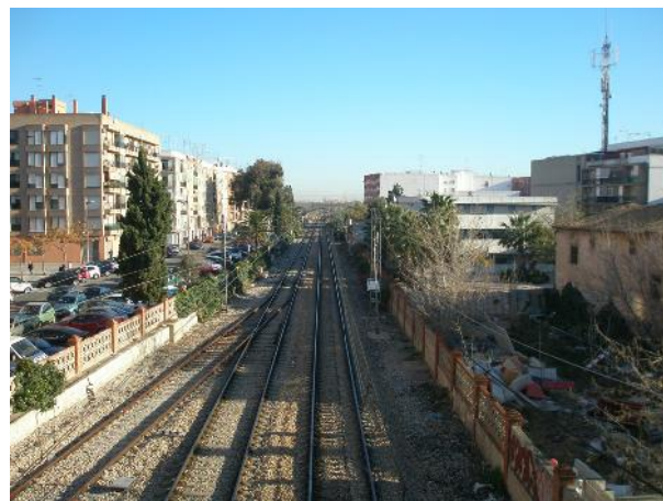
Vista Sentido Norte
