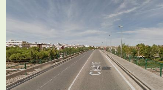
7 – Paso sobre el FF:CC. – Tráfico rodado y peatonal – CV-412
