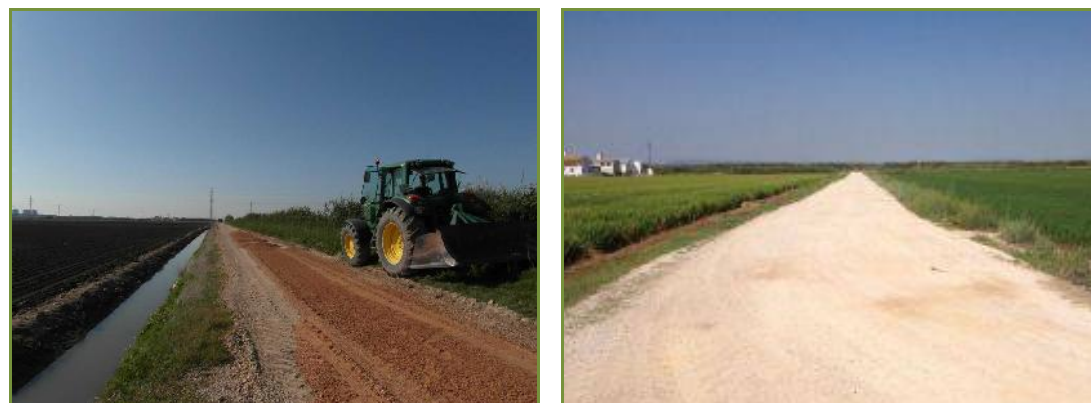
Vista de algunos de los caminos rurales y/o agrícolas recientemente acondicionados
