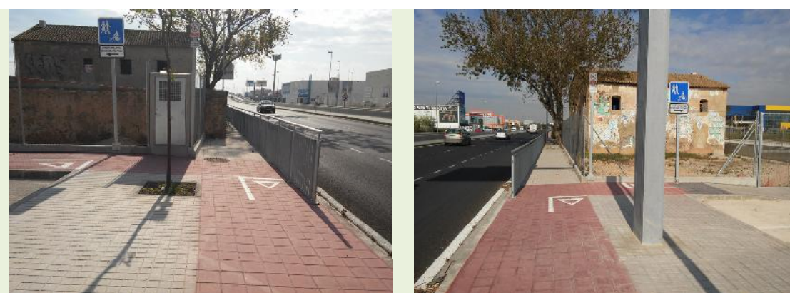
Problemas de accesibilidad derivados de la presencia de edificaciones protegidas
