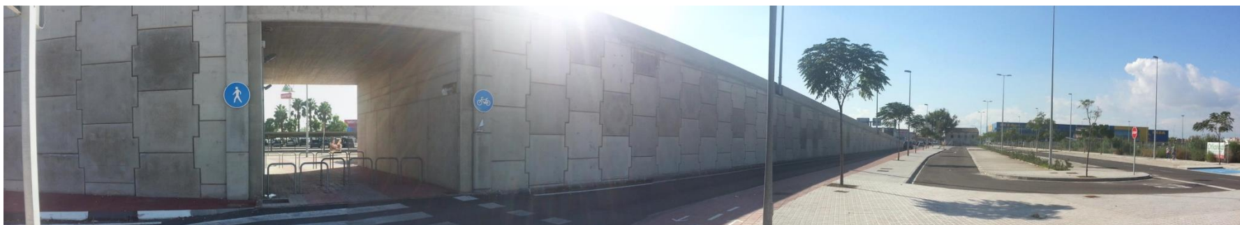
Vista desde vial de servicio, detalle de paso peatonal inferior, bajo el puente de la CV-4125
