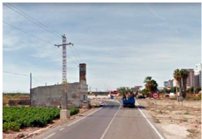
4 - Motor del Pont de Pedra
