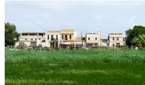
16 - Asentamiento del Tremolar en la acequia del Vall
