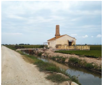
2 - Elementos patrimoniales de l'Albufera: Motores
